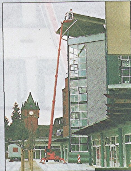
GT 25 R: Montagearbeiten
